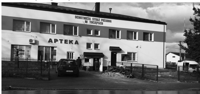
Trwa remont Domu Strażaka w Tuczępach.
