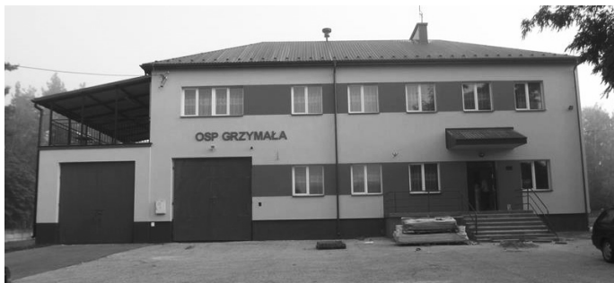
Odnowiony budynek Domu Strażaka w Grzymale.
