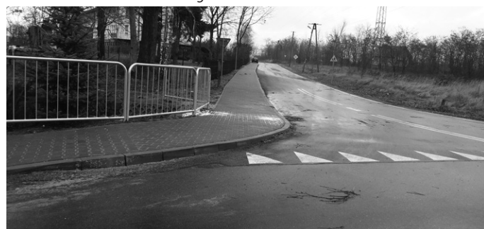
Jarosławice - od skrzyżowania do budynku gimnazjum przy nowej drodze położono chodnik.
