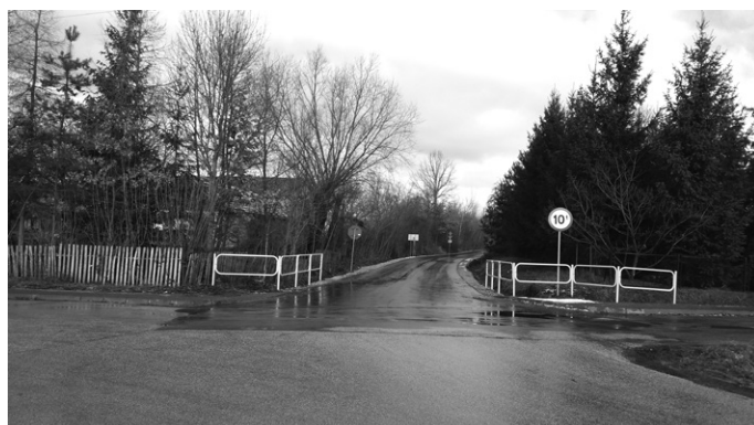
Wyremontowana droga w Tuczępach od skrzyżowania w kierunku Podlesia.
